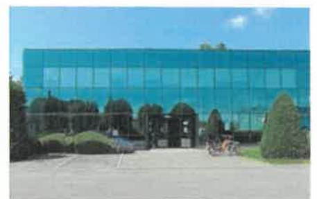
Bureaux des services Insertion et Logement
